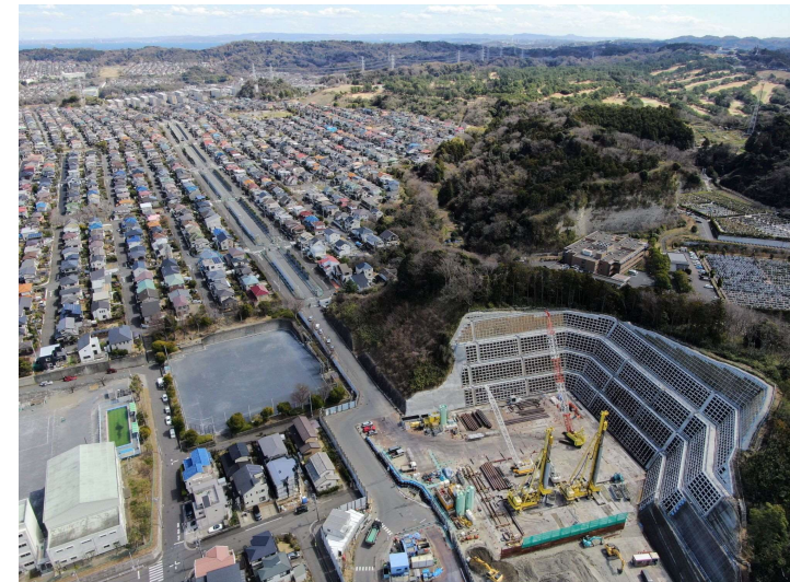
桂台TN工事側 状況
