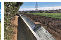
土砂流出防止対策/都筑区
